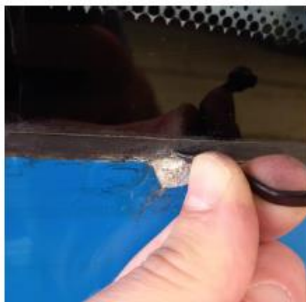
Foto 4. Beschadigde conservering waarbij rand sponning is gecorrodeerd.
