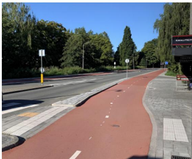
Fietspad Laan Walcheren: verbreed & geasfalteerd voor verkeersveiligheid - Amstelveen
